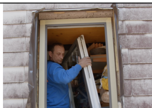
Einsetzen der Flügel bzw. Scheiben
