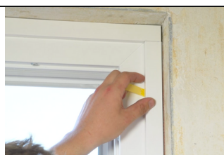
Verleimung der Wandanschlussfuge
