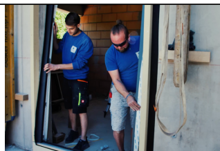
Einsetzen des Rahmens
